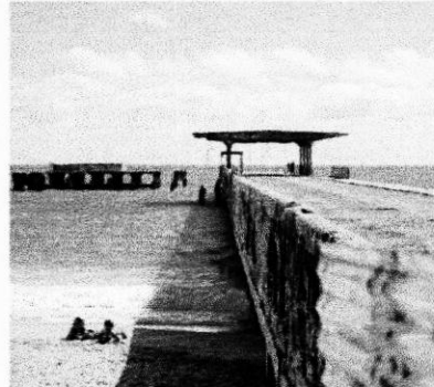
PONTE VELHA, no Poço da Draga, fechada após parte da estrutura desabar
